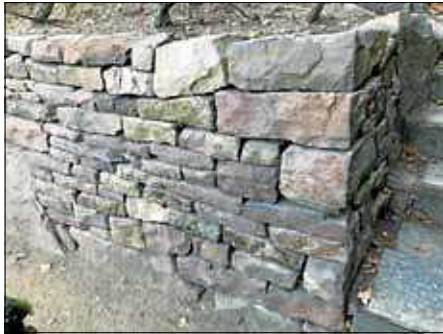
Sanierter Trockenmauer am Robberg Foto: Robbergfreunde Ettlingen e.V.
