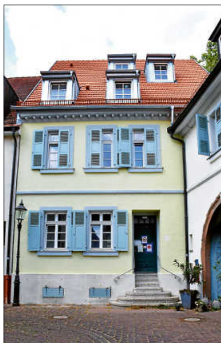
Schmuckstück: Nach der Sanierung kann sich das Anwesen Lauergasse 23 wieder sehen lassen.
