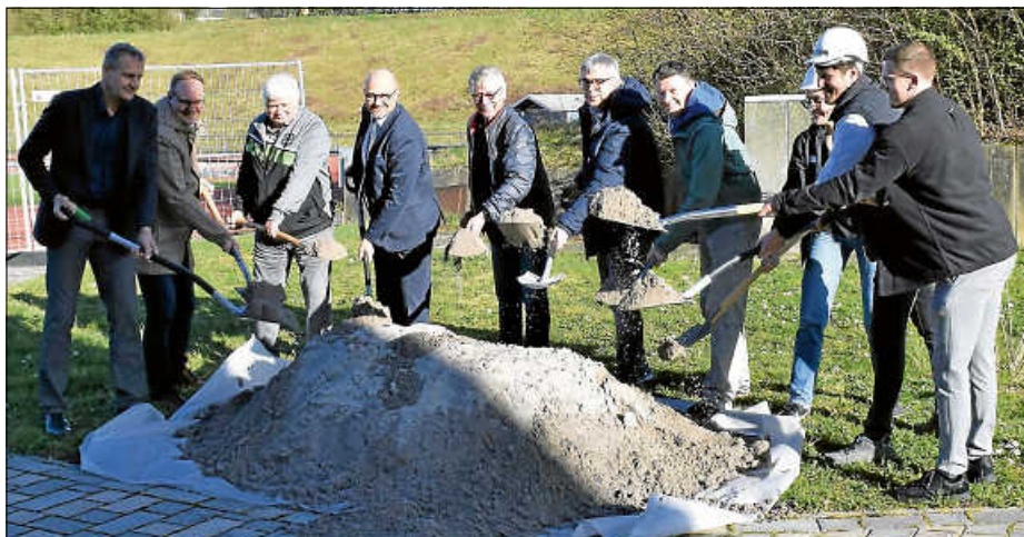
Ettlingen auf dem Weg zur ‚Sportstadt‘: gleich zwei Baustarts mit dem Spaten gab es am Donnerstag vergangener Woche: für das Lager am Hans-Bretz-Stadion...
