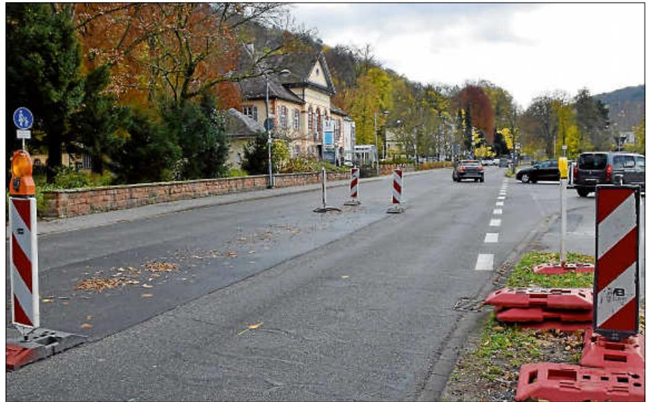
Die Vorbereitungen für die Montage der Mittelinsel sind erledigt, in der kommenden Woche werden die Bauteile im Kreuzungsbereich montiert.
