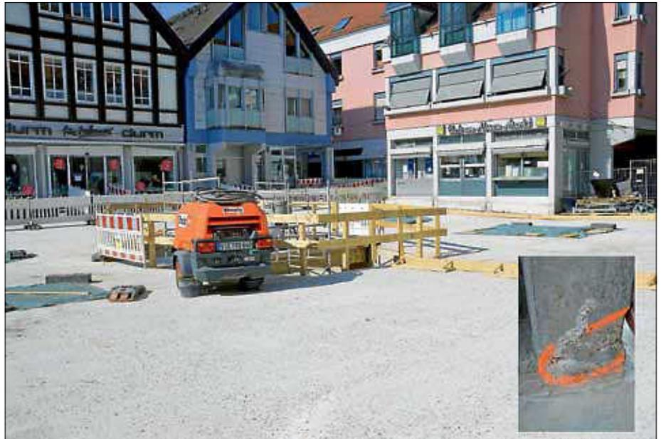
*Stark ausgekieselt ist der Beton der Tiefgaragendecke und der Häusersockel am Neuen Markt, so dass teilweise die Armierungseisen frei lagen und korrodierten.*
