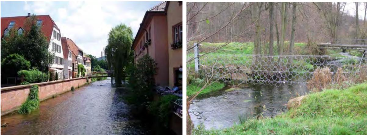
Abbildung 5-7: Hochwasserschutzmauern in der Altstadt und Treibholzfang an der Alb flussaufwärts (Quelle: Aland und Stadtbauamt)
