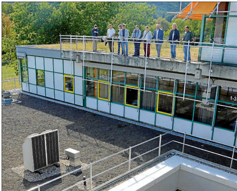
Eines der drei sanierten Dächer des Schulzentrums. Architekten, Schulleiter nebst OB und Fachleute aus der Verwaltung beim Vor-Ort-Termin.
