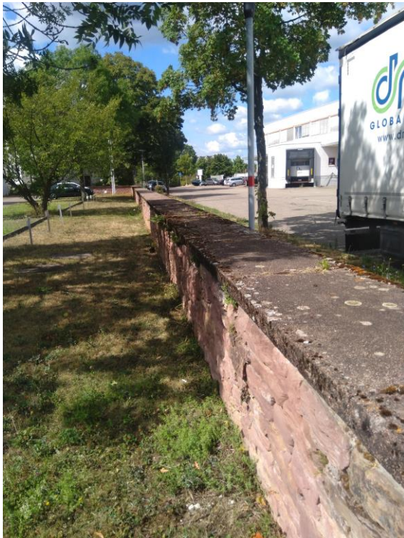
Abbildung 12: Sandsteinmauer (Haupthabitat der Mauereidechsen im UG)
