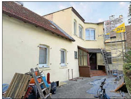
Instandgesetzte Fassade unseres Vereinsheims Foto: ECV
