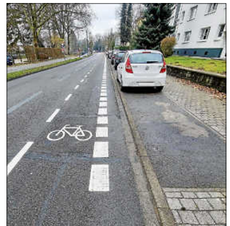
Schutzstreifen mit Sicherheitsabstand zu parkenden Autos Foto: Fritz Wengler
