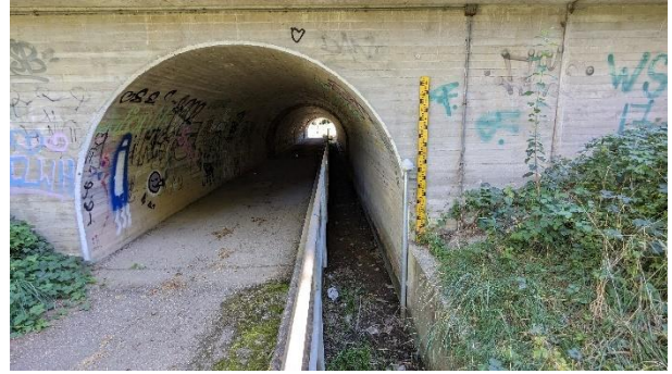
Abbildung 82: Durchlass des Scheidgrabens (zum Erfassungszeitpunkt trocken gefallen) unter der Autobahn.
