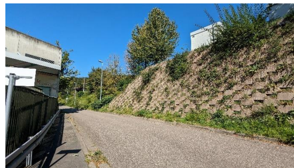
Abbildung 94: Mauer aus Pflanzsteinen als Trittstein für Arten der trockenwarmen Lebensräume am Bahnhof Busenbach.
