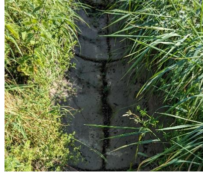
Abbildung 88: Betonhalbschalen in einem Graben westlich Ettlingenweiler.
