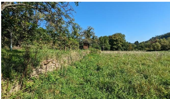
Abbildung 91: Besonnte Trockenmauer in ehemaligem Rebgebiet Mauerreben südlich Ettlingenweier.
