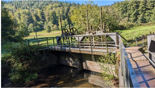
Abbildung 81: Wehranlage an der Alb zur Ableitung des Mühlkanals „Obere Fabrik“ südlich der Kläranlage.
