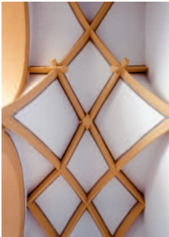
Blick in das renaissancezeitliche Rippengewölbe der Arkaden
