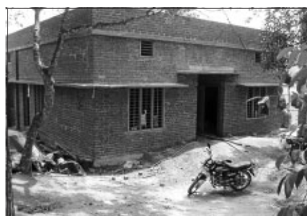
Vorderseite des neuen Backhauses - Stand Anfang Juli
