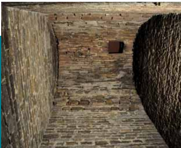
Blick in das Gewölbe des mittelalterlichen Bergfrieds
